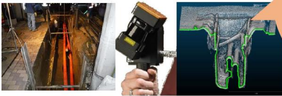
掘削状況の3D計測
